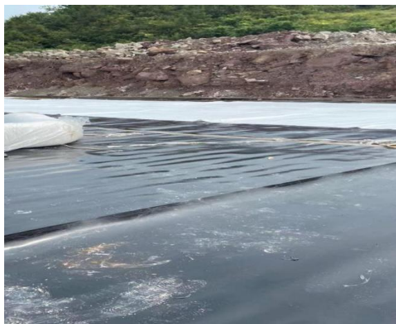
循环水池、事故应急水池、污水处理池抗渗材料敷设施工
