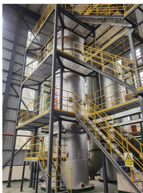
烟气净化工艺中二级喷淋脱酸装置
