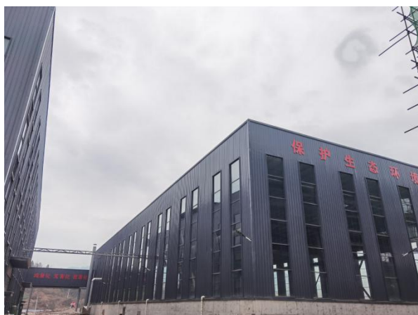
油基岩屑暂存库
