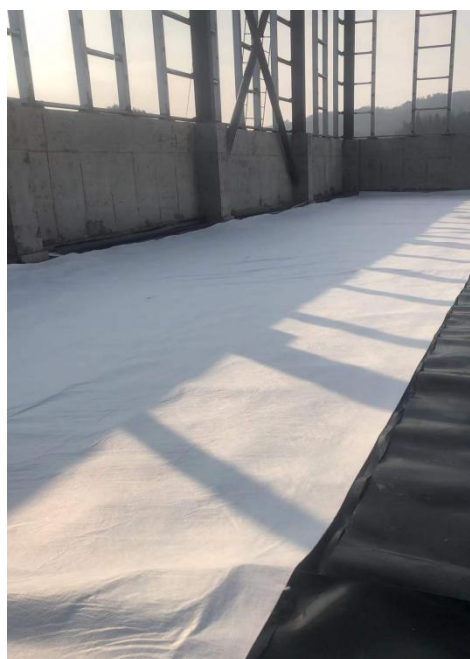
循环水池、事故应急水池、污水处理池抗渗材料敷设施工
