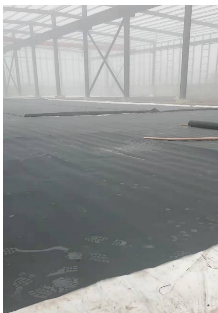
循环水池、事故应急水池、污水处理池抗渗材料敷设施工
