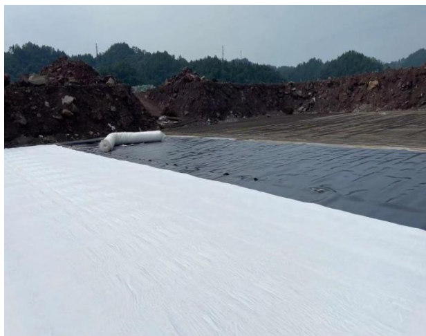
循环水池、事故应急水池、污水处理池抗渗材料敷设施工
