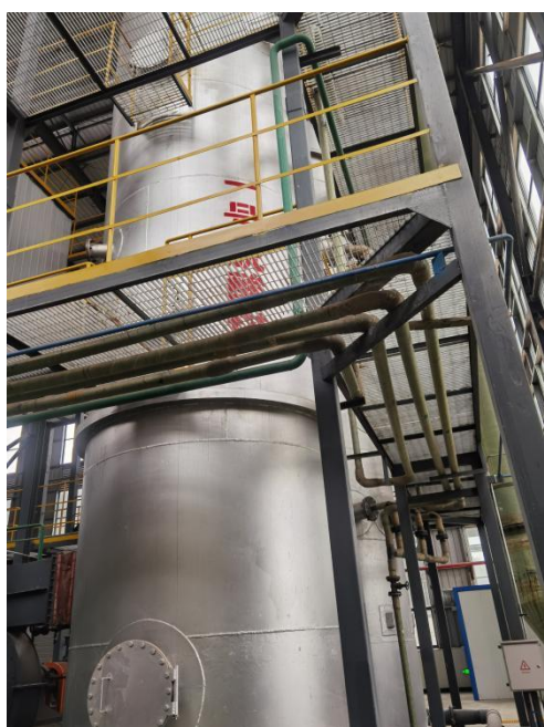
烟气净化工艺中二级喷淋脱酸装置
