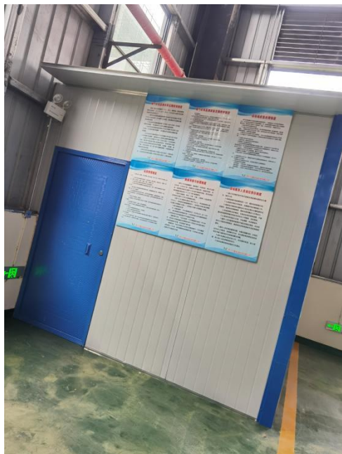
废气在线监测室
